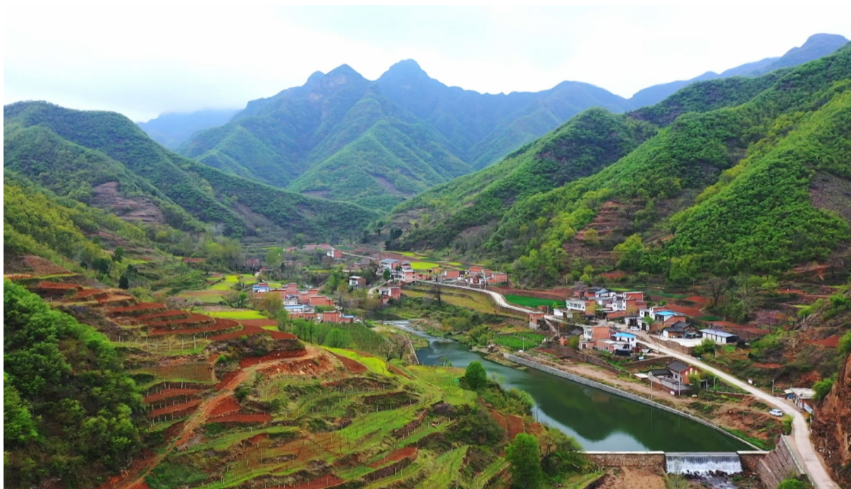
图 3-2 河南省嵩县小流域水土流失综合治理工程
