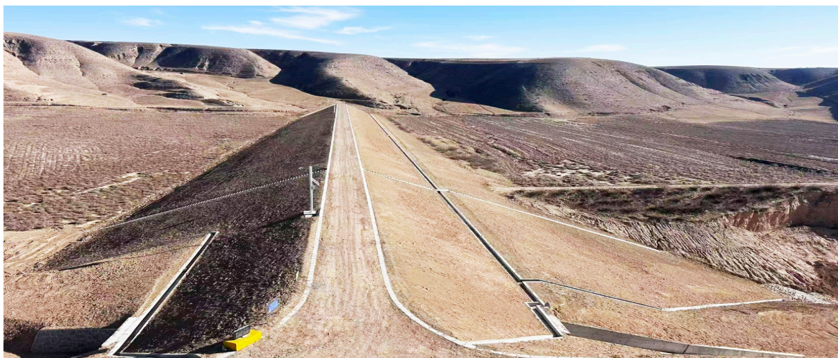
图 3-6 宁夏回族自治区同心县淤地坝工程
