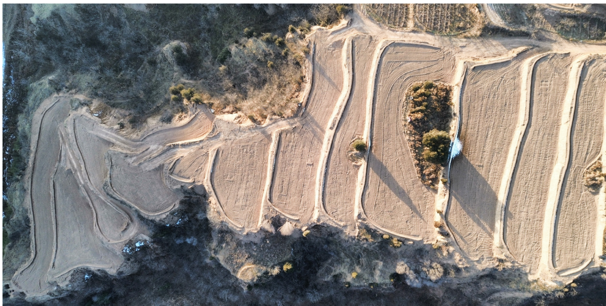
图 3-4 山西省平陆县坡耕地水土流失综合治理工程
