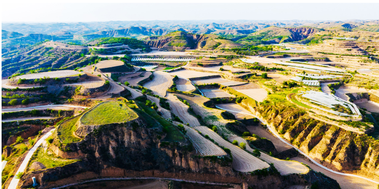
图 3-5 陕西省米脂县坡耕地水土流失综合治理工程
