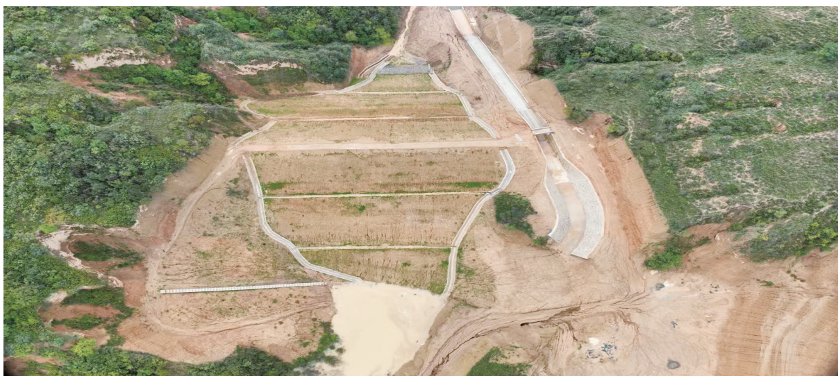
图 3-7 山西省蒲县淤地坝工程
