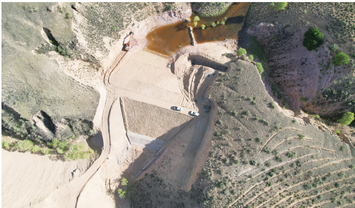
图 3-8 内蒙古自治区准格尔旗拦沙坝工程
