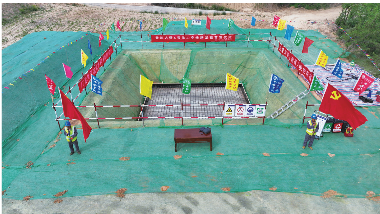
图 4-8 黄河古贤水利枢纽工程施工区水土保持临时防护
