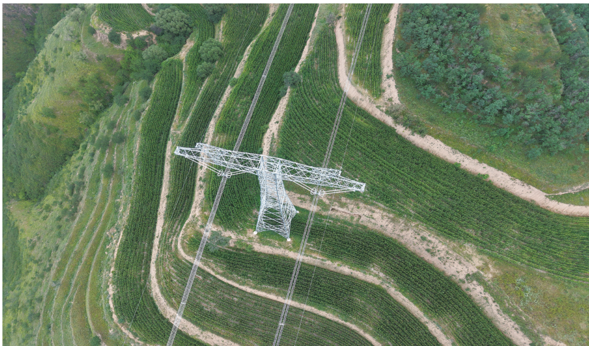
图 4-3 宁夏 - 湖南 ±800 千伏特高压直流输电工程甘肃段 N0846 塔基区复垦
