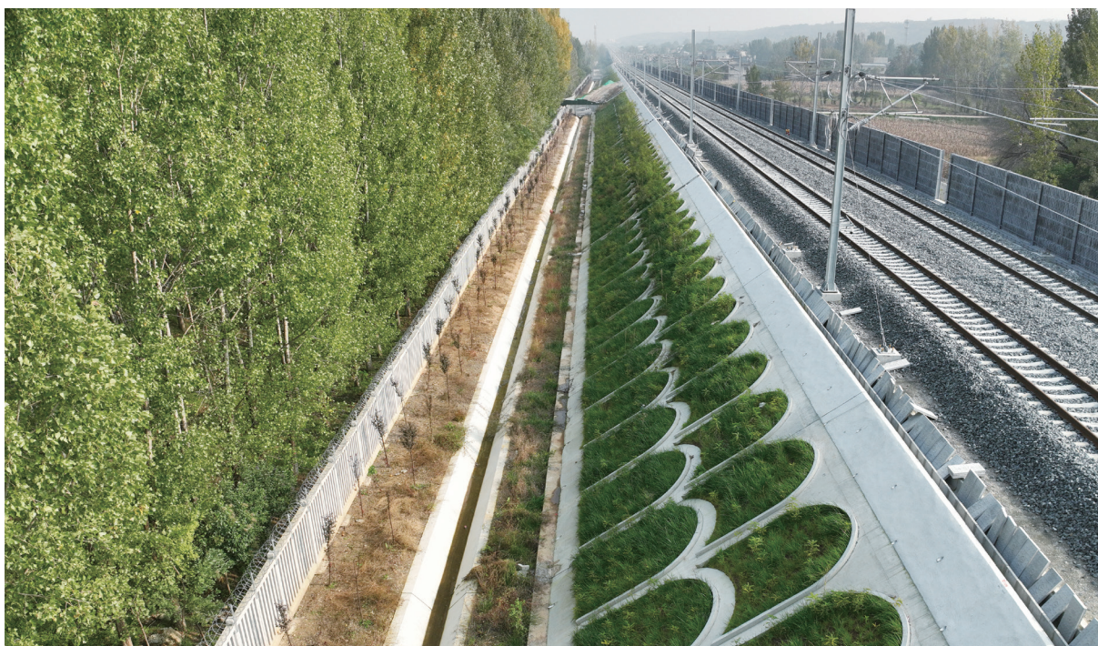
图 4-6 新建铁路西安至十堰线路基水土保持综合措施护坡
