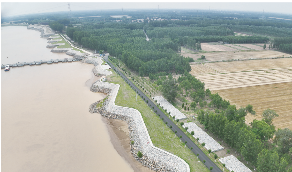
图 4-7 黄河下游“十四五”防洪工程山东济南济阳防汛路绿化
