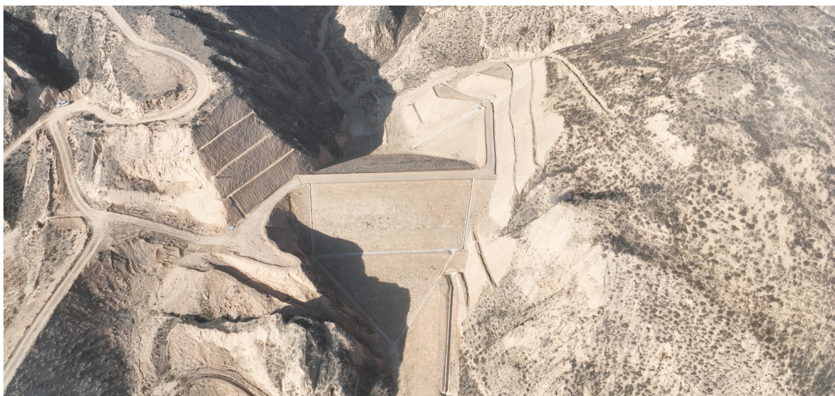
图 3-11 陕西省榆林市横山区淤地坝除险加固工程
