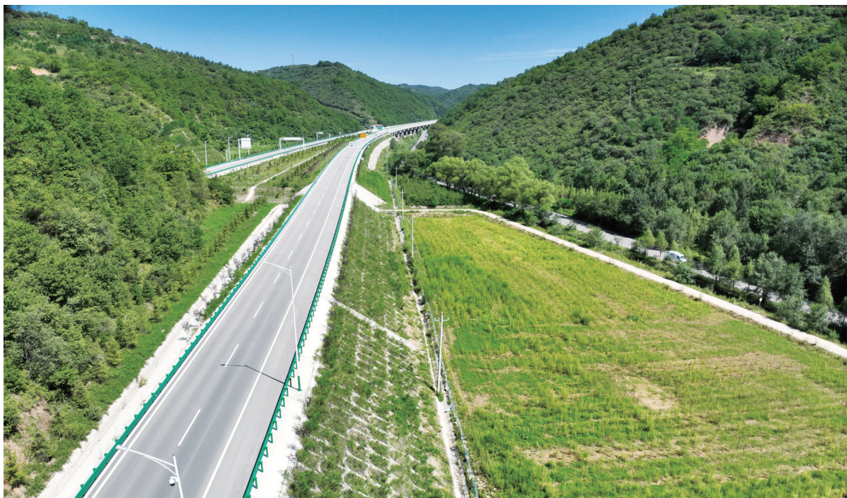
图 4-1 银川至昆明国家高速公路（G85）彭阳（甘宁界）至平凉至大桥村（甘陕界）段工程 6 标路基边坡水土保持综合治理
