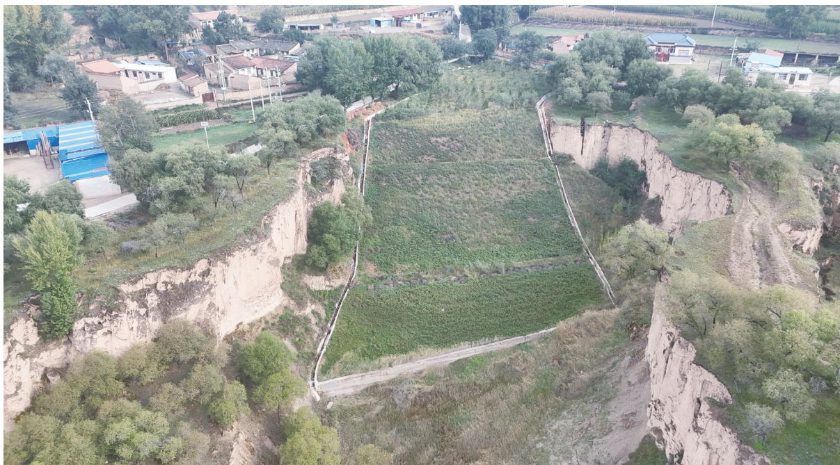
图 4-5 引洮供水二期总干渠 34# 隧洞 5# 支洞弃渣场区综合治理
