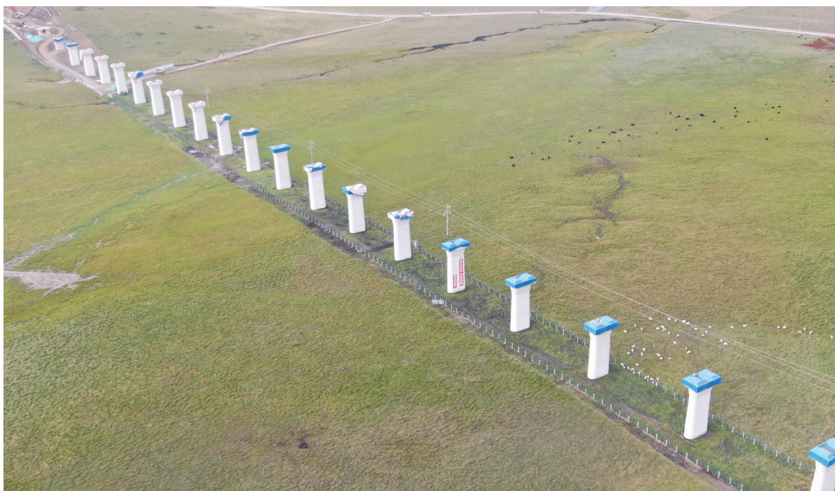
图 4-2 新建西宁至成都铁路（四川段）跨国道 G213 特大桥扰动区植被恢复
