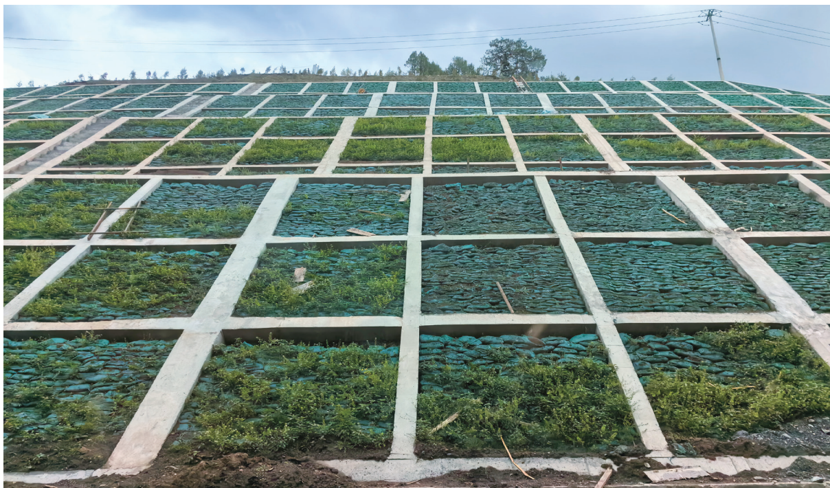
图 5-3 G0611 张掖至汶川高速同仁至赛尔龙（青甘界）段 公路工程边坡混凝土骨架结合植生袋综合防治水土流失
