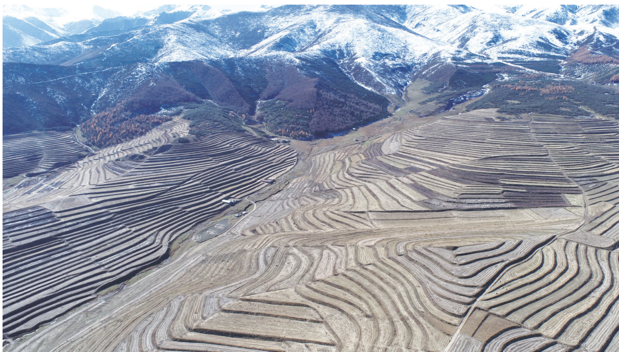
图 4-1 青海省大通回族土族自治县小流域水土流失综合治理工程
