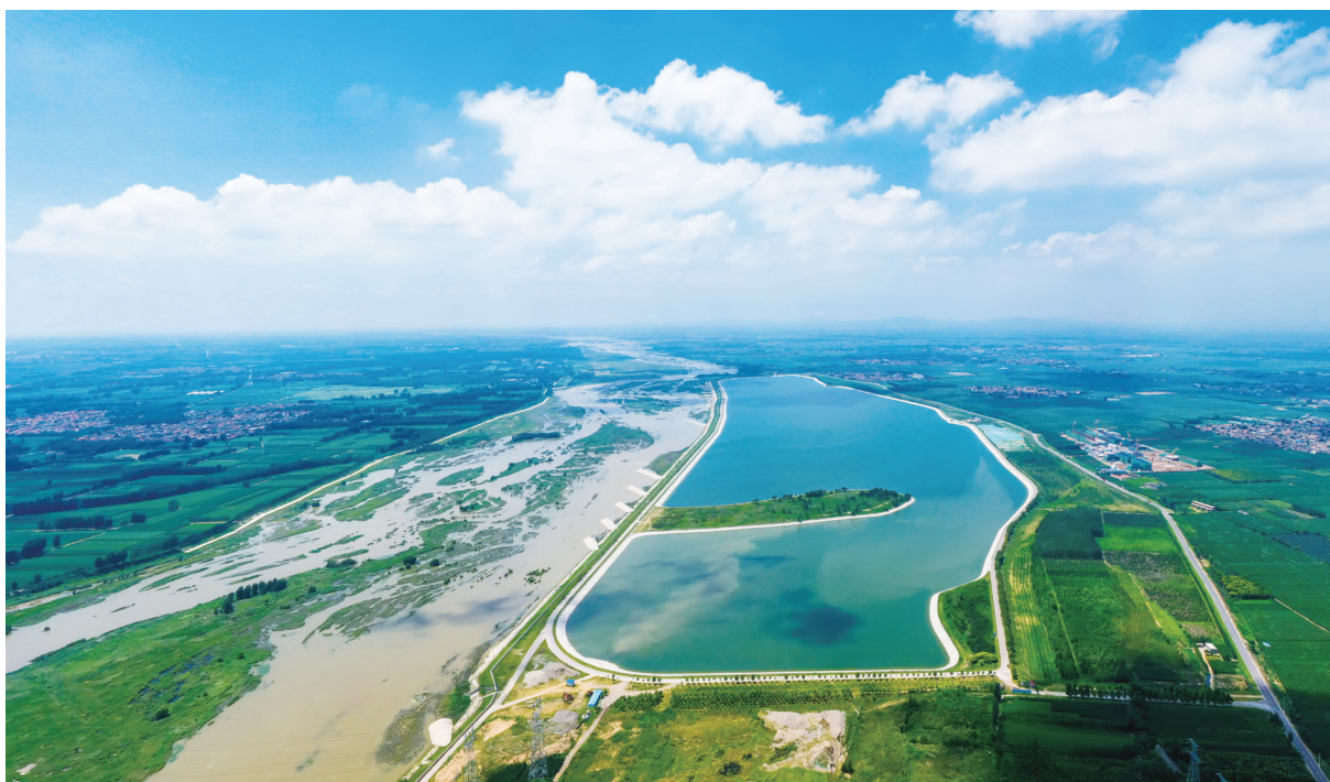
图 5-6 山东泰安王家院水库向泰城供水工程水土流失综合防治
