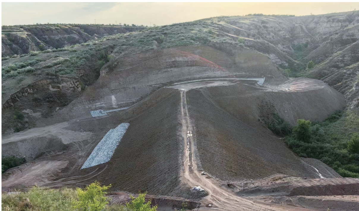
图 4-8 内蒙古自治区准格尔旗拦沙工程
