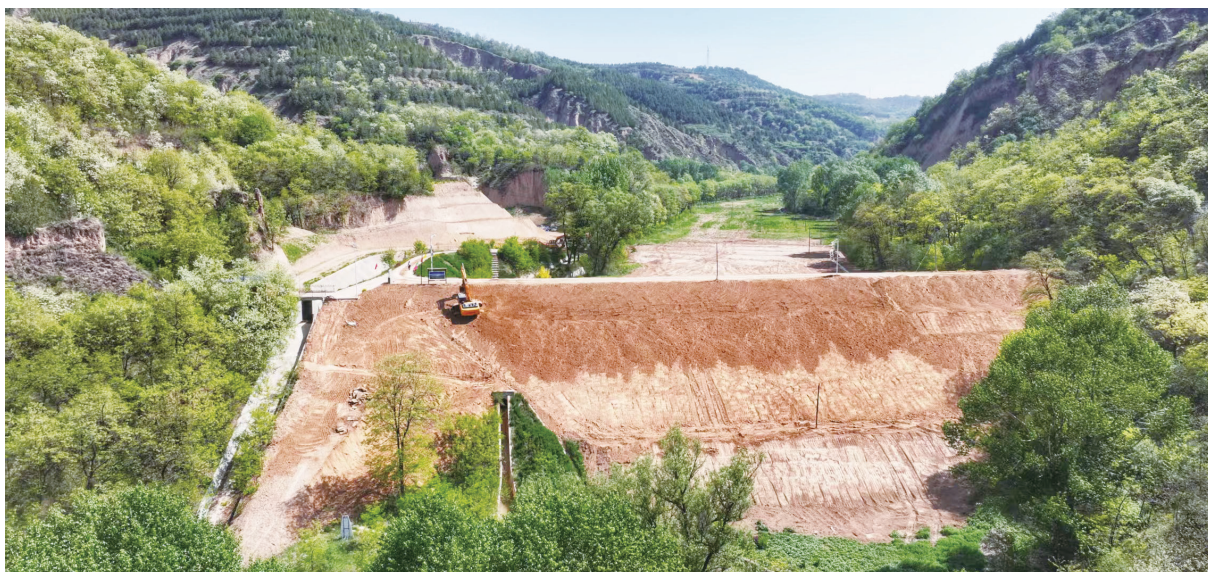
图 4-11 黄委南小河沟小流域淤地坝提升改造工程
