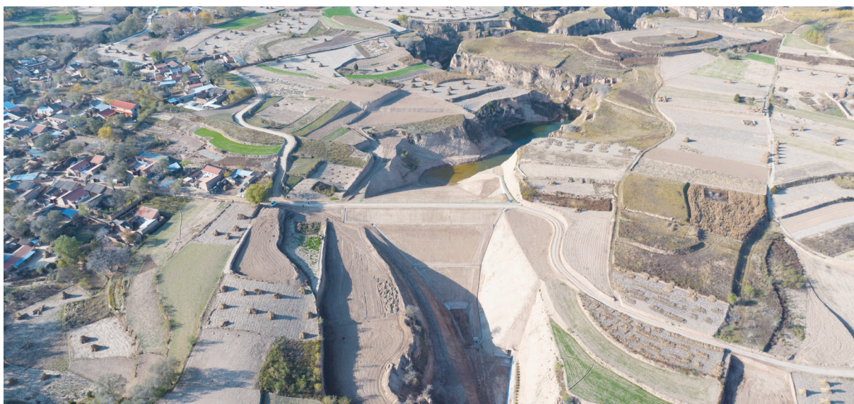
图 4-6 甘肃省通渭县淤地坝工程
