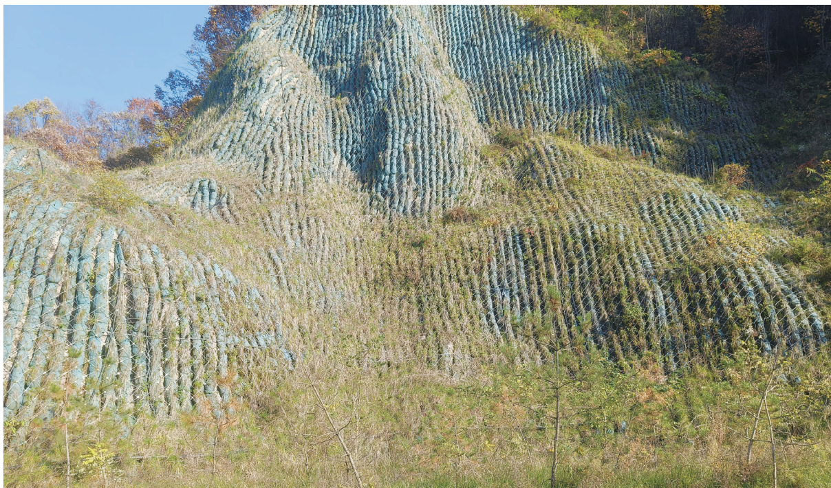
图 5-5 陕西金堆城钼业股份有限公司王家坪尾矿库项目道路边坡植生袋防治水土流失
