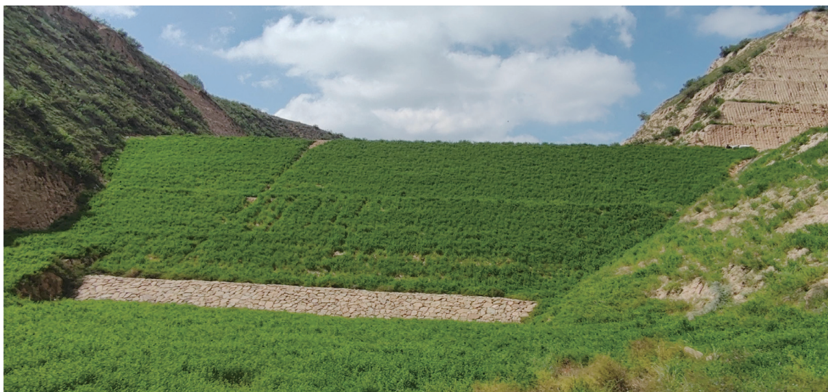
图 4-7 陕西省靖边县淤地坝工程
