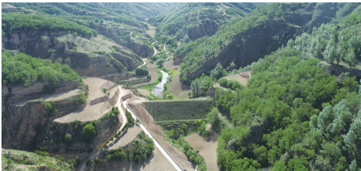
图 4-10 山西省永和县淤地坝除险加固工程
