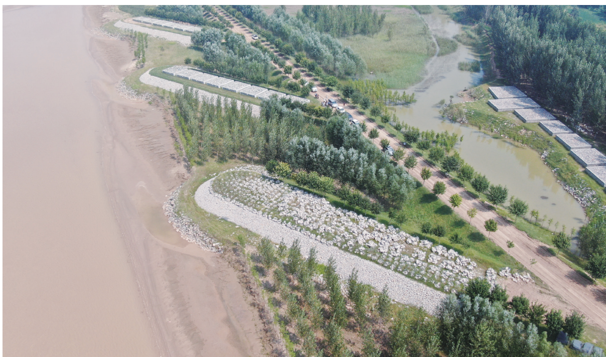
图 5-7 黄河下游防洪工程（山东段）控导续建工程植树种草保护水土资源
