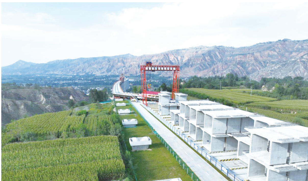
图 5-8 新建兰州至合作铁路 4 标泄湖峡大夏河特大桥扰动区水土保持植草措施
