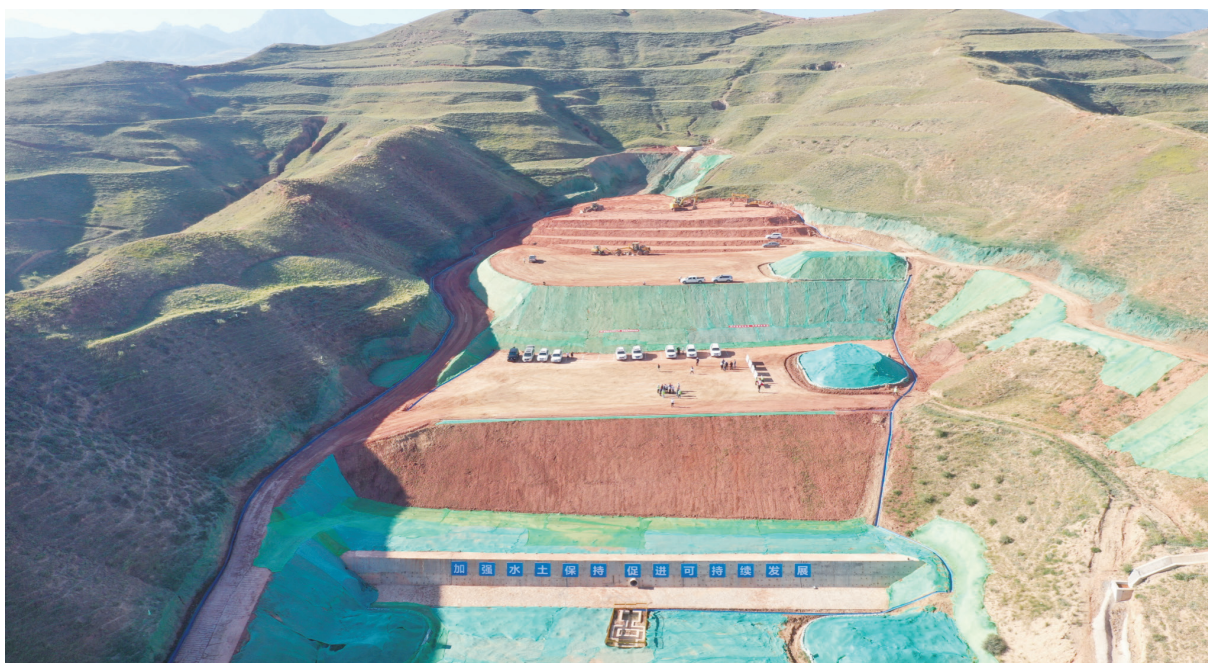
图 5-2 新建西宁至成都铁路西宁至黄胜关段（甘青段） 新庄一号隧道弃渣场边弃边治综合防治水土流失
