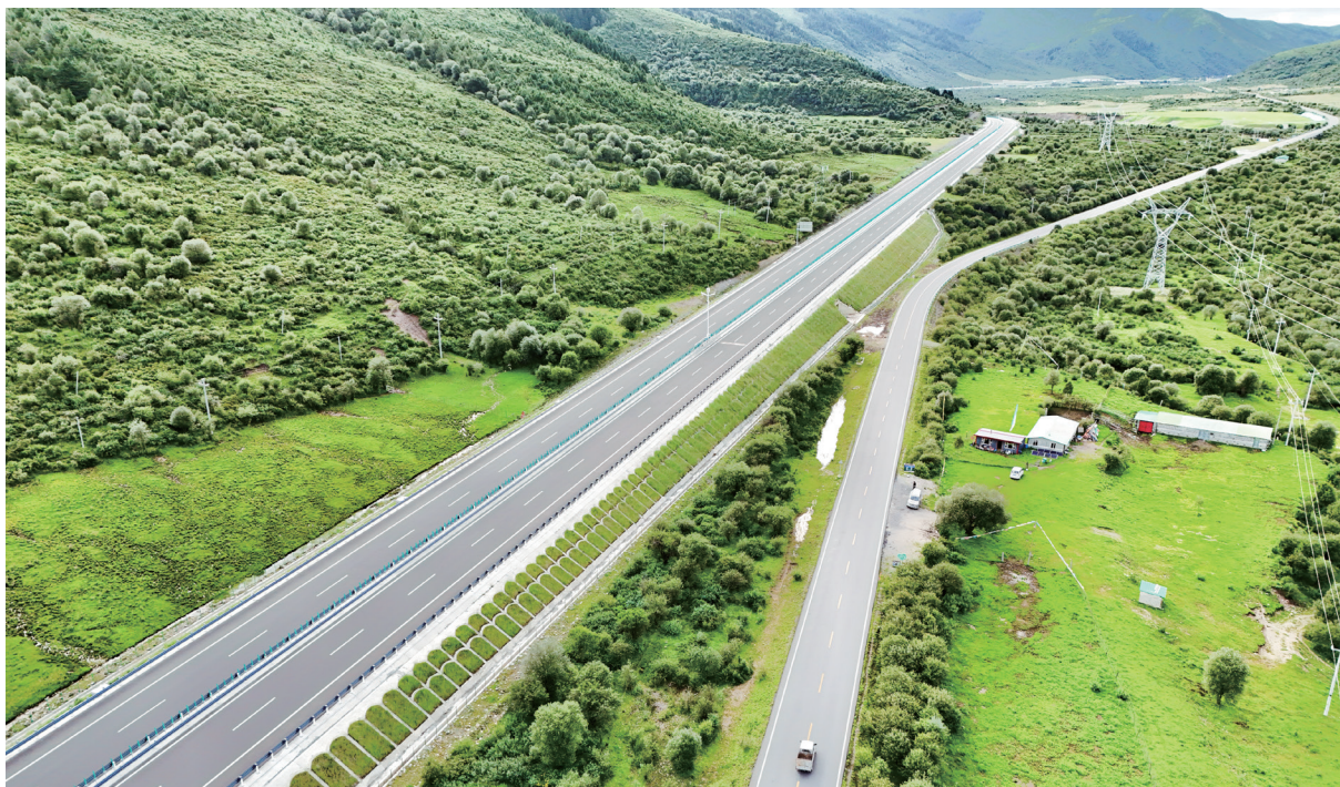
图 5-1 四川久马高速路基边坡拱形骨架结合植草防治水土流失
