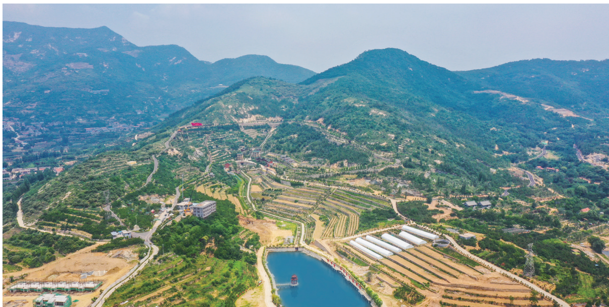
图 4-5 山东省泰安市泰山区坡耕地水土流失综合治理工程
