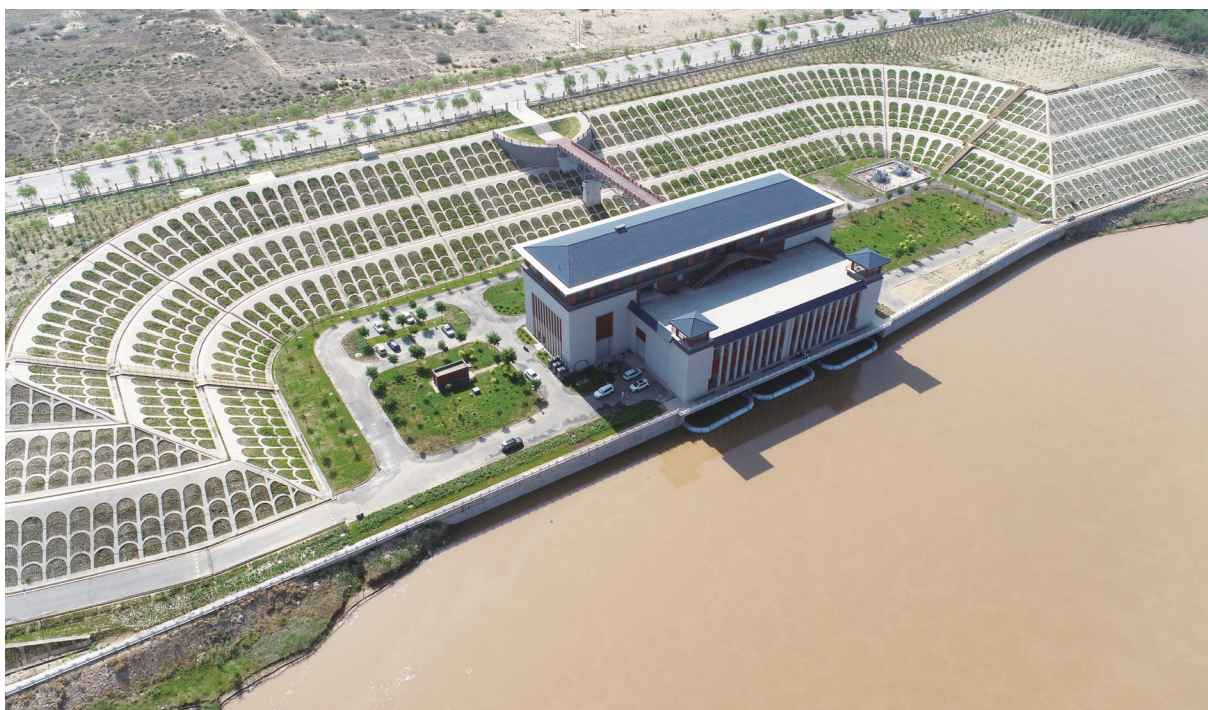
图 5-4 银川都市圈中线供水工程泵站边坡混凝土网格植草防治水土流失
