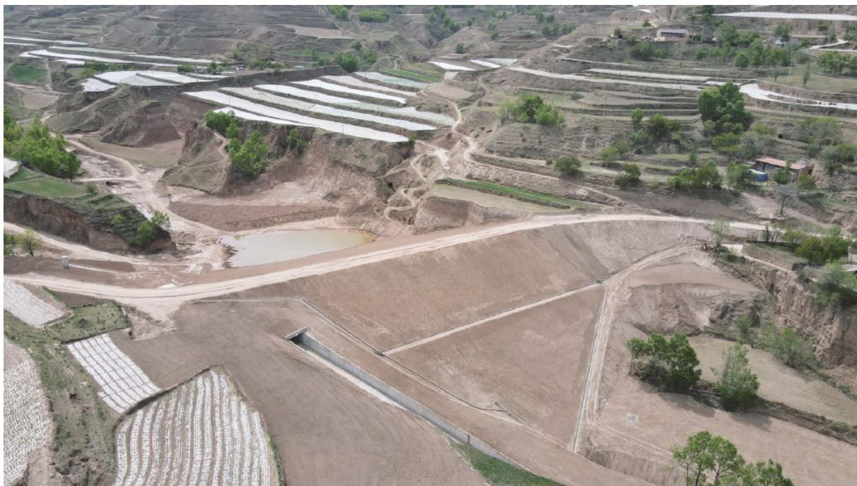
图 3-10 甘肃省定西市临洮县五脏沟大二型新建淤地坝
