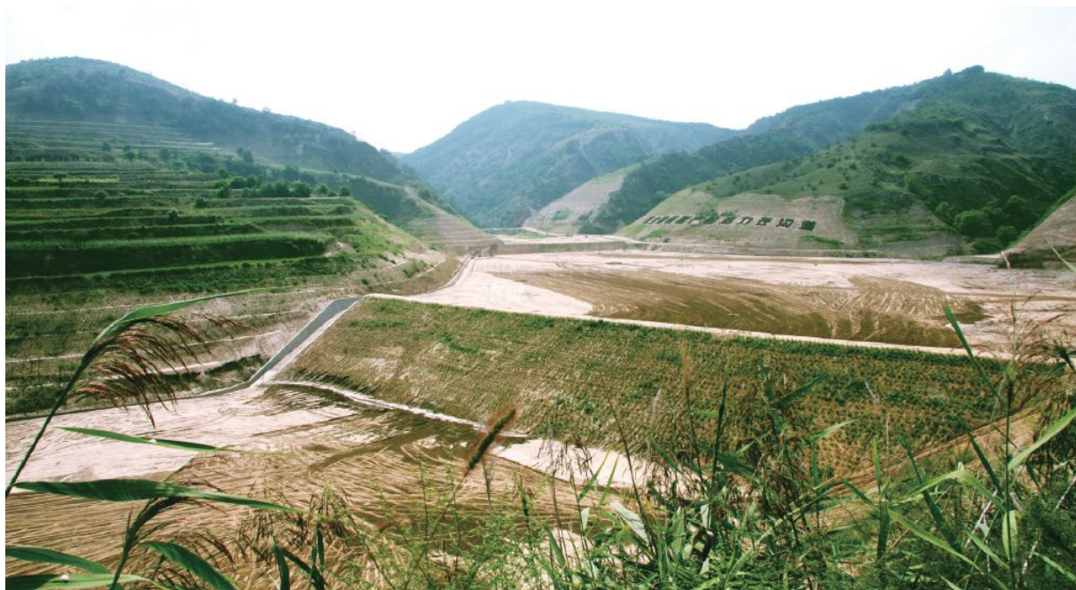
图 2-4 山西省子长县寺湾西山沟淤地坝
