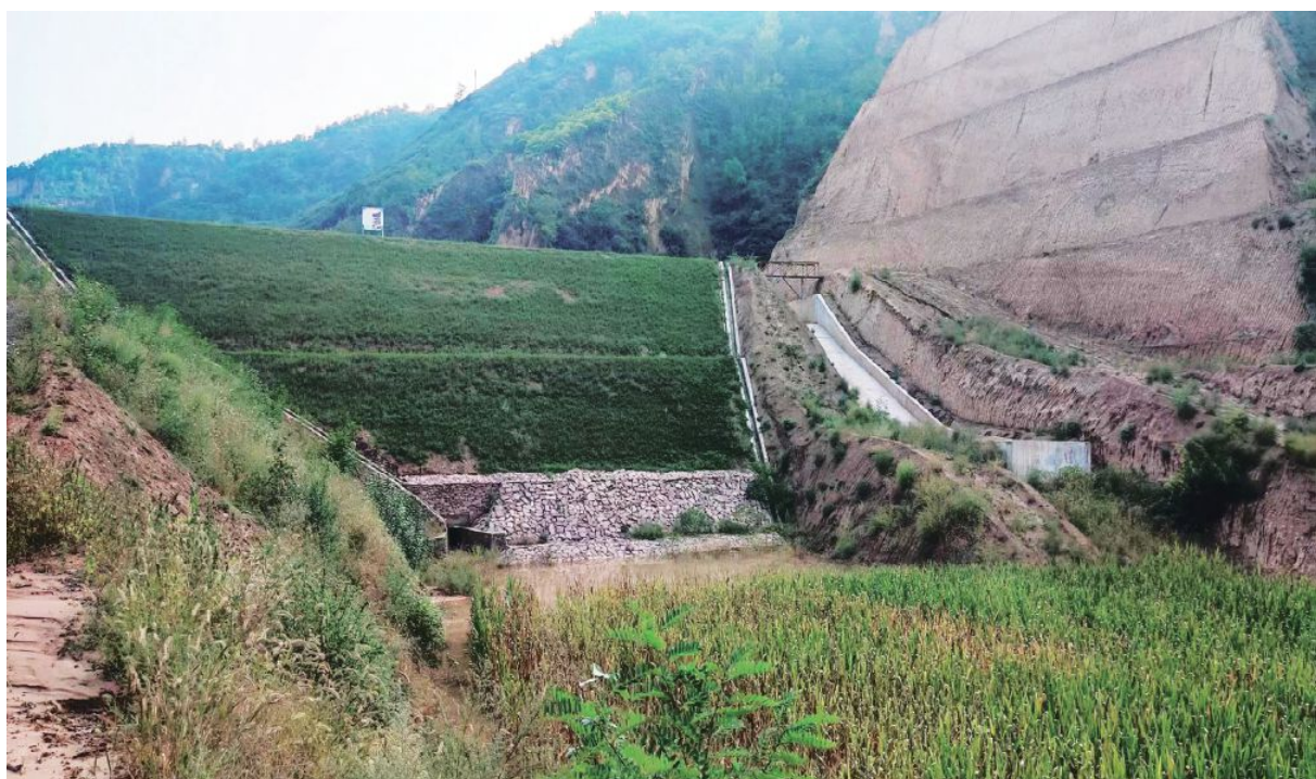
图 3-11 山西省临汾市乡宁县西坡中型淤地坝除险加固工程
