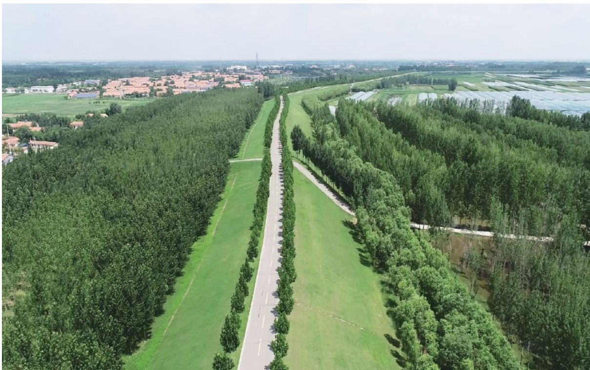
图 4-5 山东省黄河下游防洪工程堤防加固工程植被恢复
