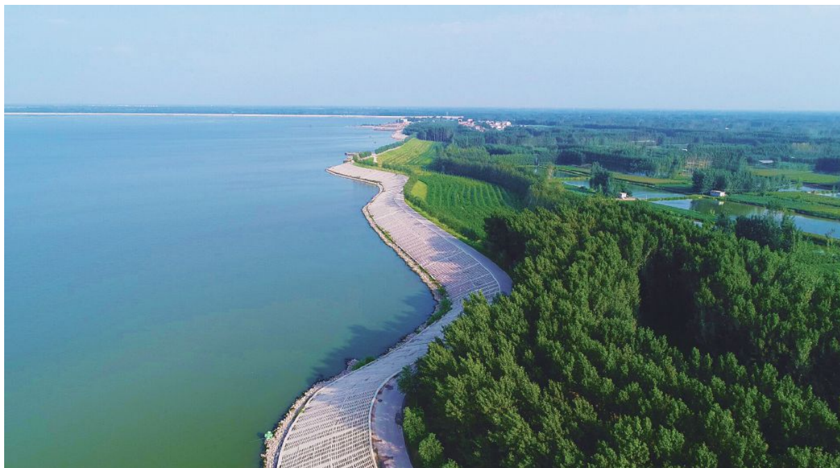
图 4-6 山东省黄河东平湖蓄滞洪区防洪工程主体工程建设及植被恢复
