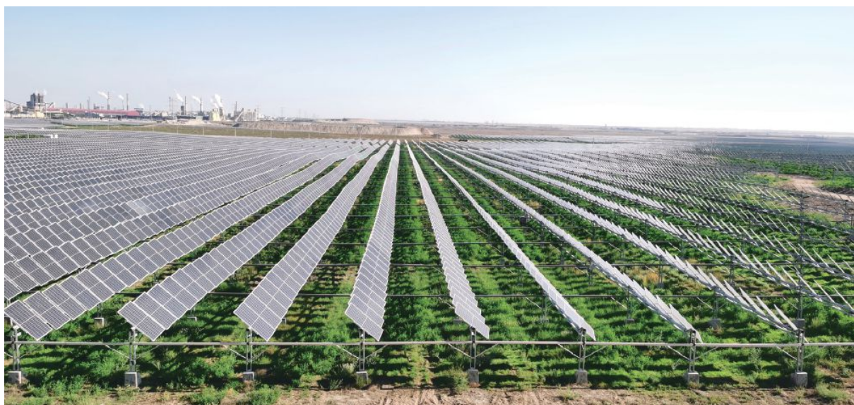
图 4-3 宁夏京能宁东 150MW 集中式光伏复合发电项目光伏电站区植被恢复
