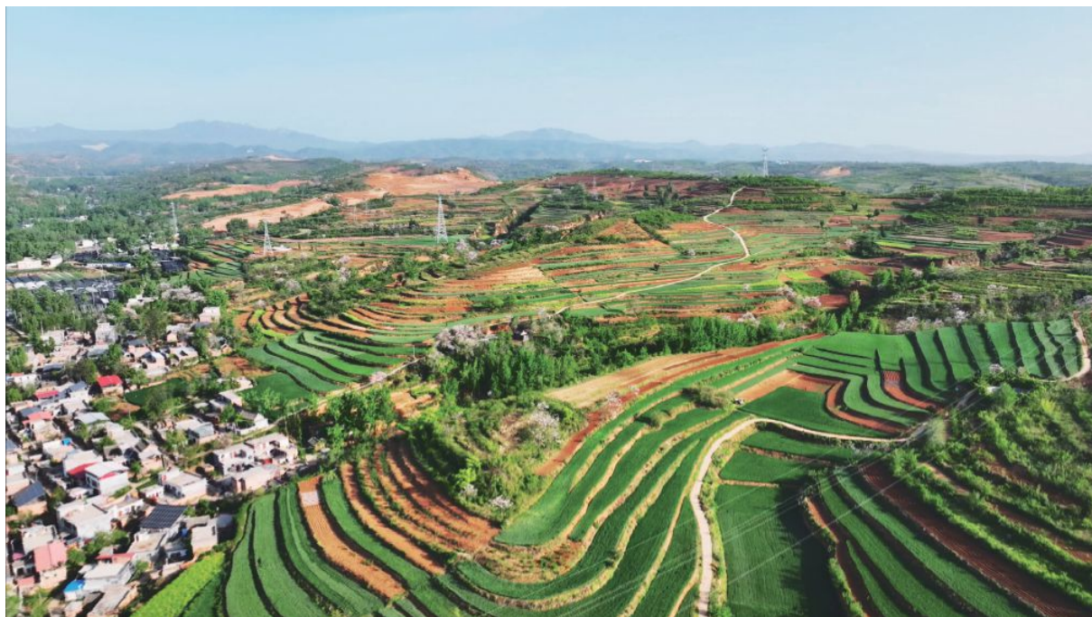
图 3-2 河南省嵩县何村黄寨川坡耕地水土流失治理
