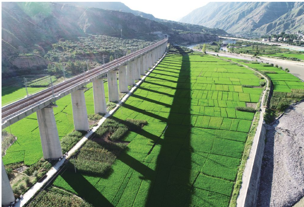
图 4-2 甘肃省新建铁路兰州至重庆线－桥梁工程区植被恢复
