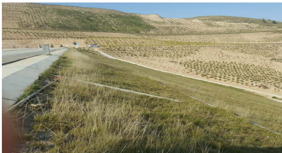
水库大坝坝坡及挖方边坡综合防护
