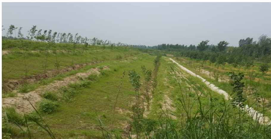
弃渣场植草及排水措施
