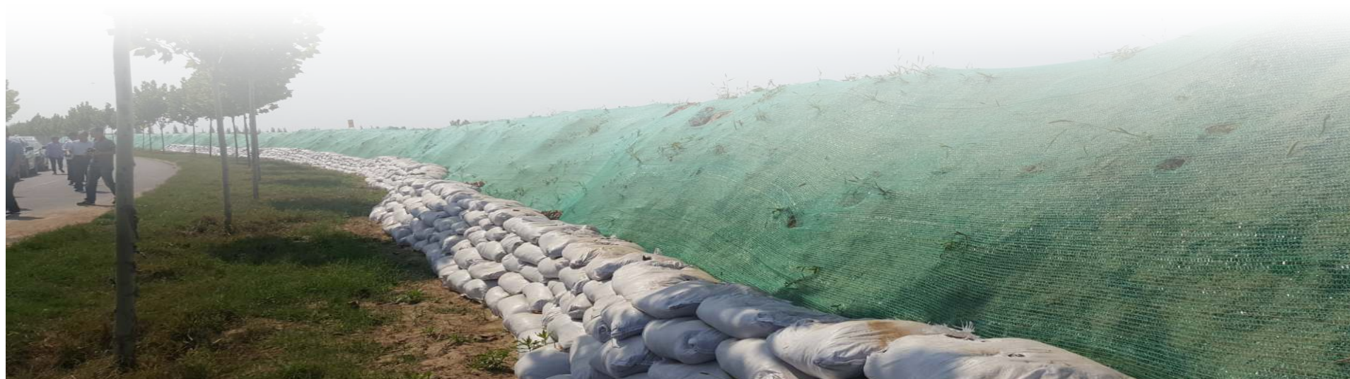
剥离表土集中堆放及临时防护
