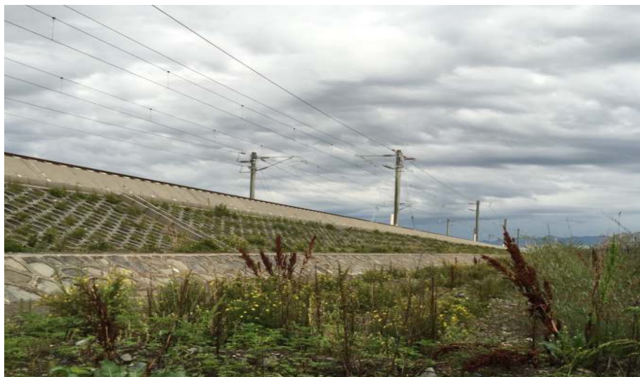
铁路路基边坡防护及绿化带
