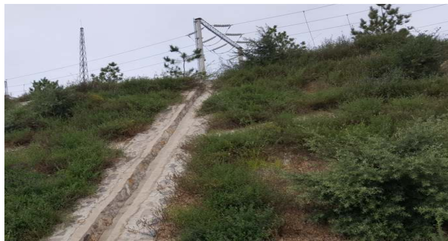
铁路路基边坡防护及排水沟
