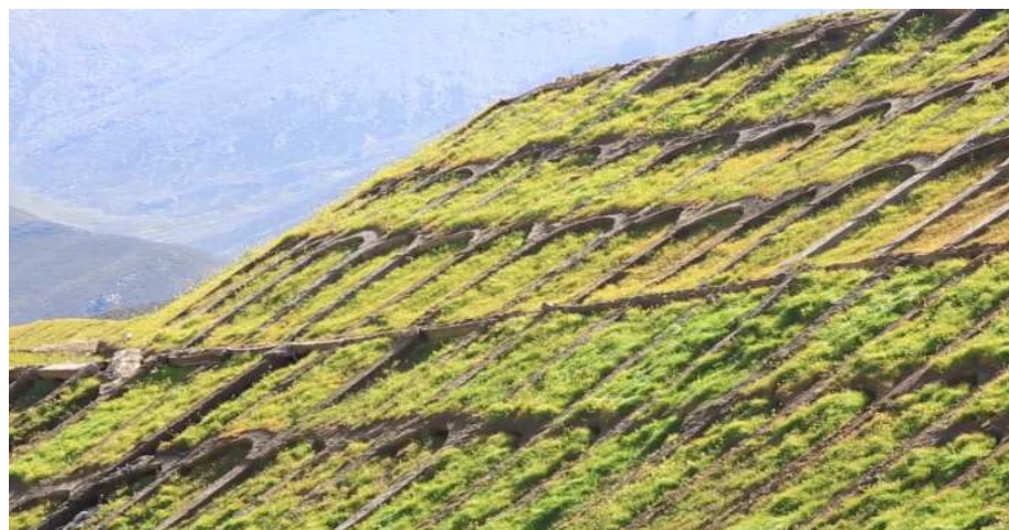
铁路路堑高陡边坡水土流失综合防治
