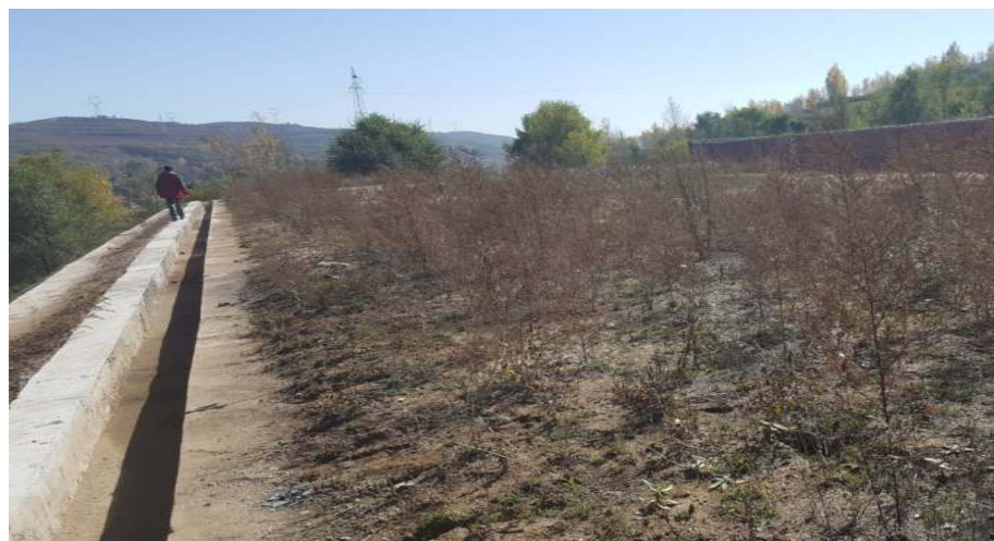
弃渣顶部平整绿化及排水沟
