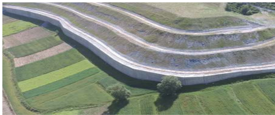
弃渣场水土流失综合治理
