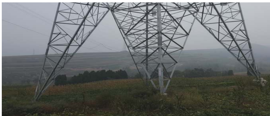
输变电线路塔基区复耕
