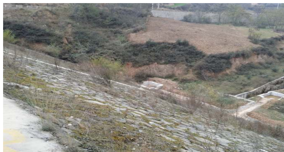
电厂贮灰场边坡防护及排水系统
