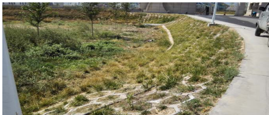
进场道路边坡综合防治
