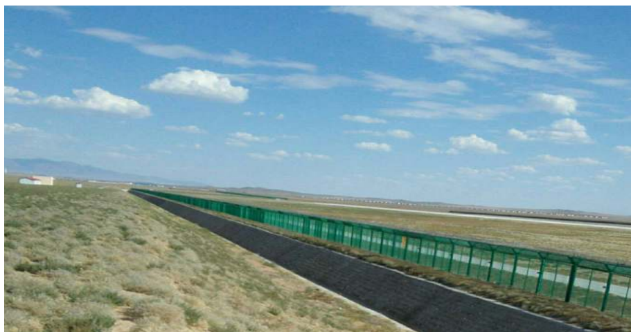
机场飞行区边坡防护及排水
