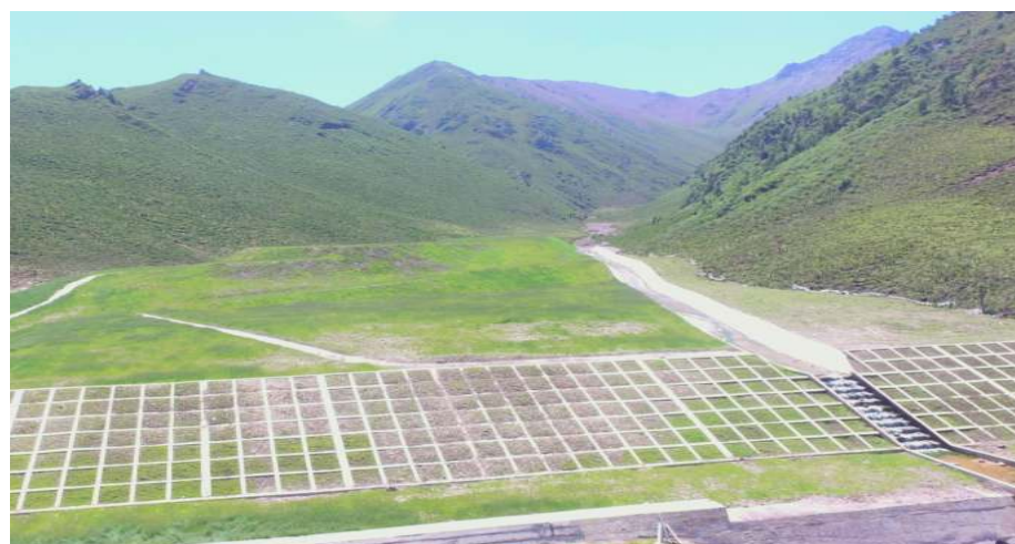
沟道弃渣场水土流失综合防治
