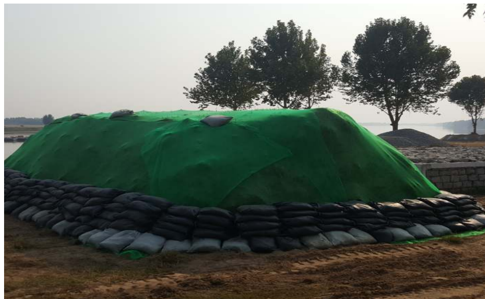
临时堆土苫盖及袋装土护脚
