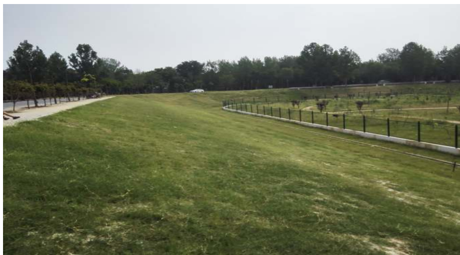
大堤边坡植草保持水土
