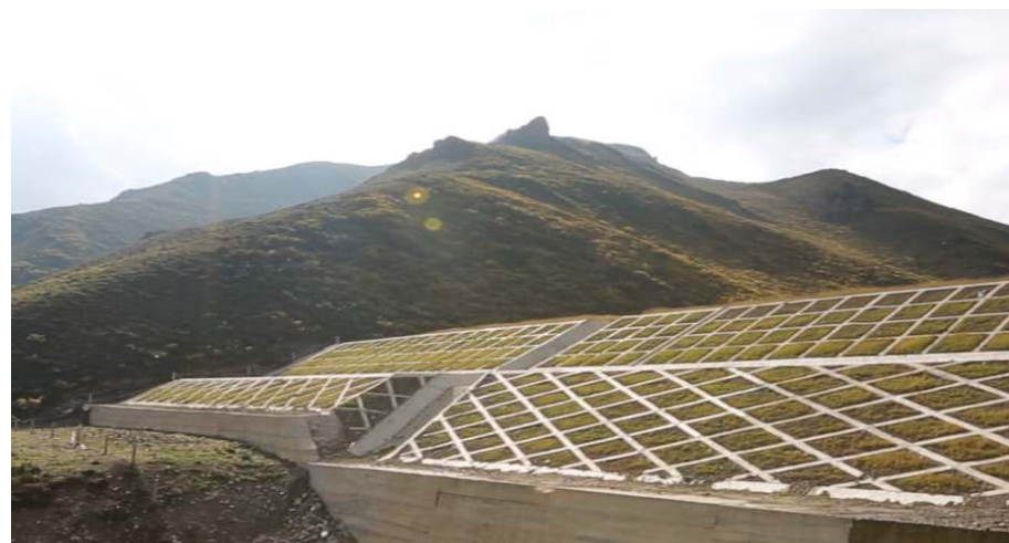
弃渣场挡墙、排水和综合护坡
