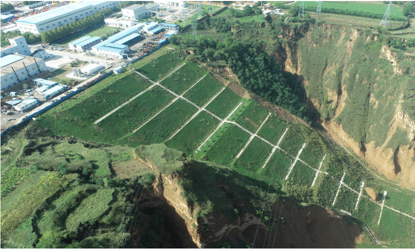
煤矿项目排矸场综合治理
