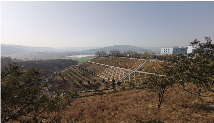
煤矿主井厂区水土保持综合治理
