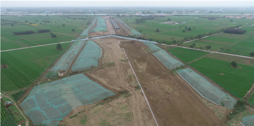
输水工程临时堆土苫盖防护
