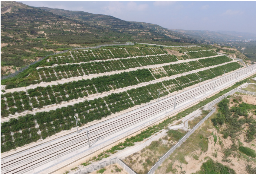
高速铁路边坡综合防治
