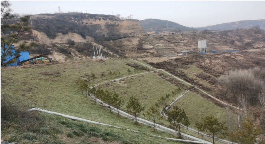
煤矿排矸场综合治理
