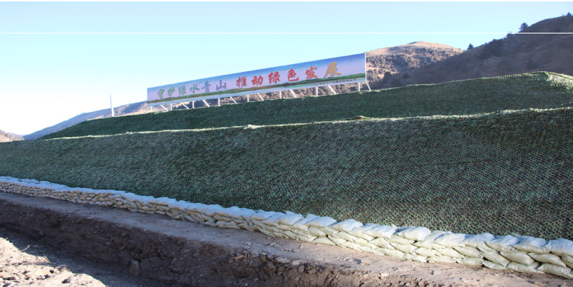
高速铁路剥离表土集中堆放保护
