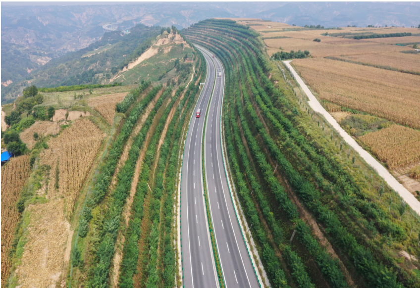
高速公路边坡水土保持综合治理
