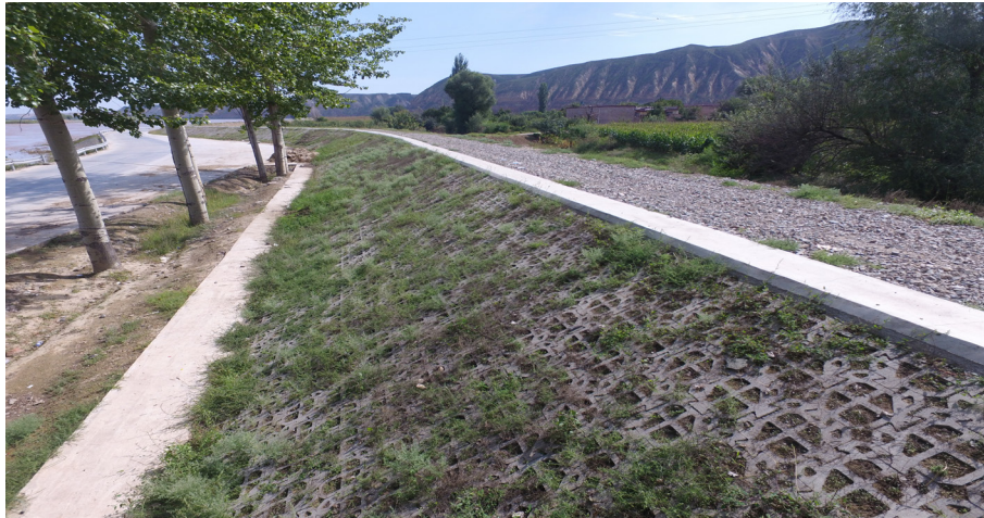
防洪治理工程水土保持
