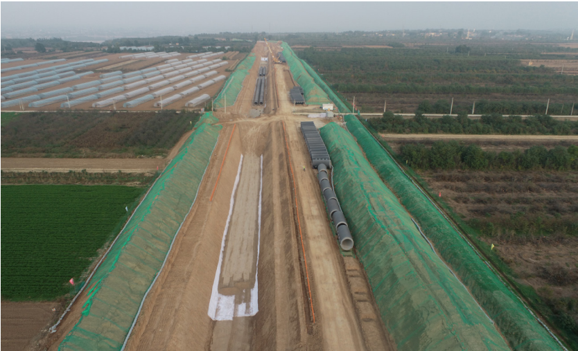
输水工程表土保护及临时堆土苫盖防护
