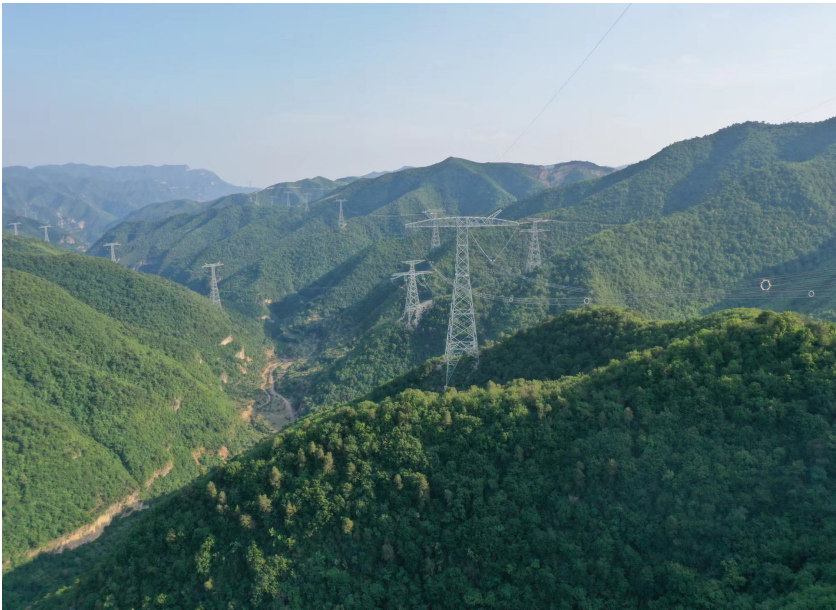
特高压输电线路植被恢复
