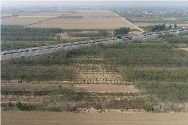
管道工程植被恢复
