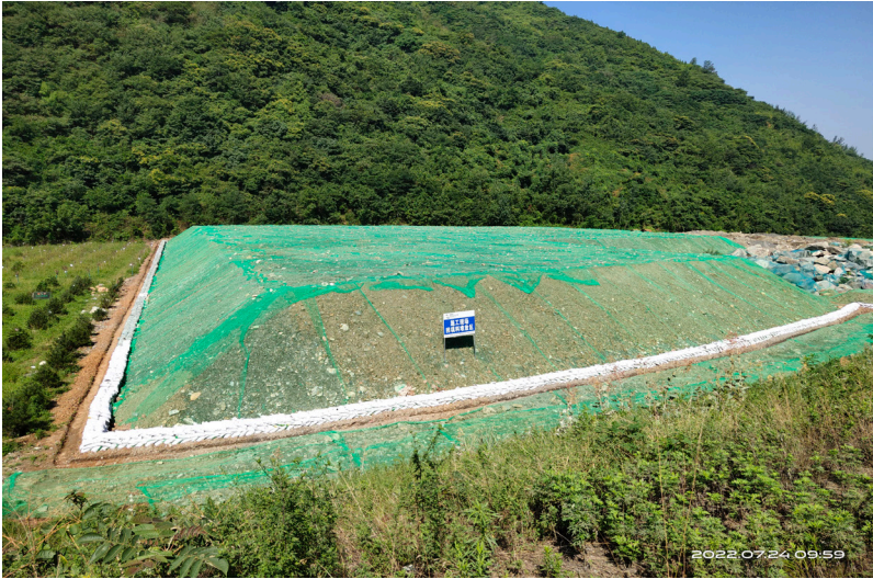
输水工程临时堆料防护
