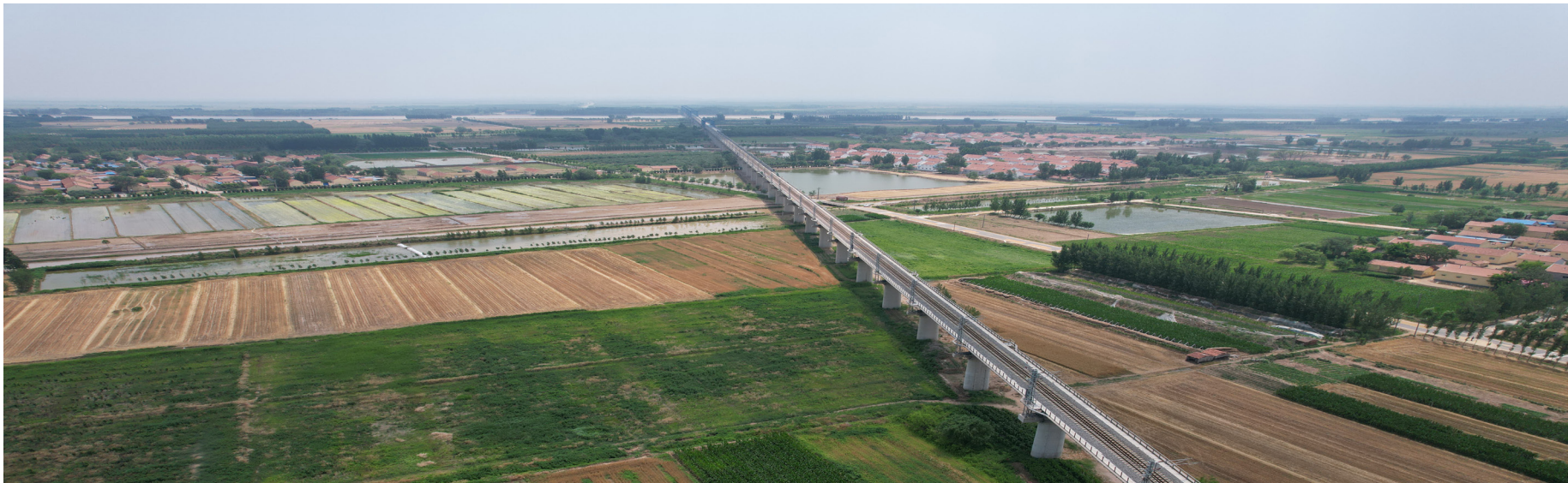
铁路工程特大桥水土保持
