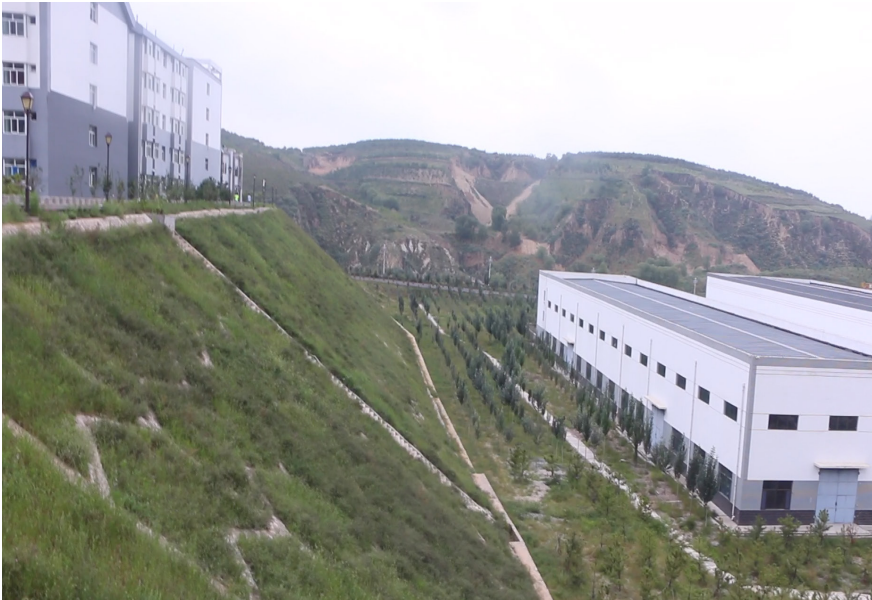
煤矿项目人字骨架工程结合植草护坡
