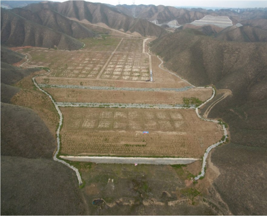
弃土场渣面块状整地
