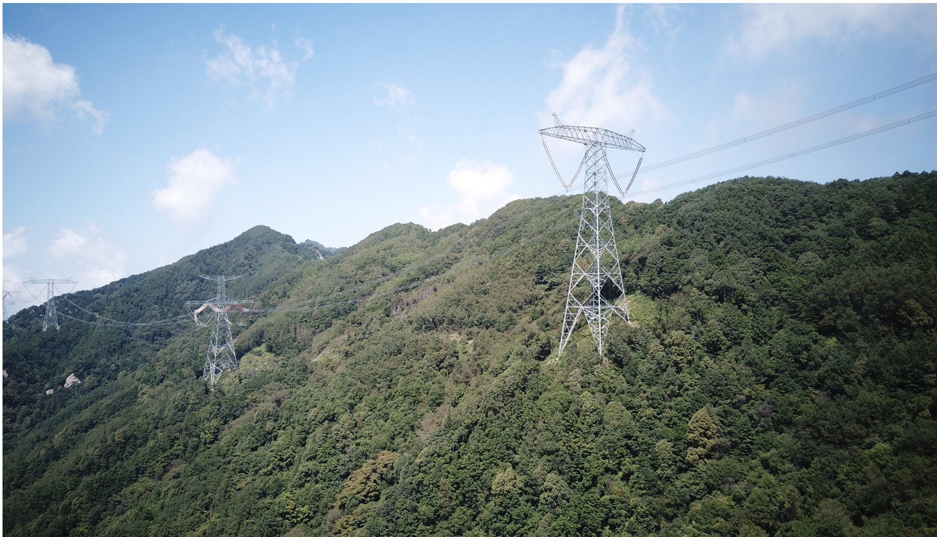
输变电路塔基区植被恢复
