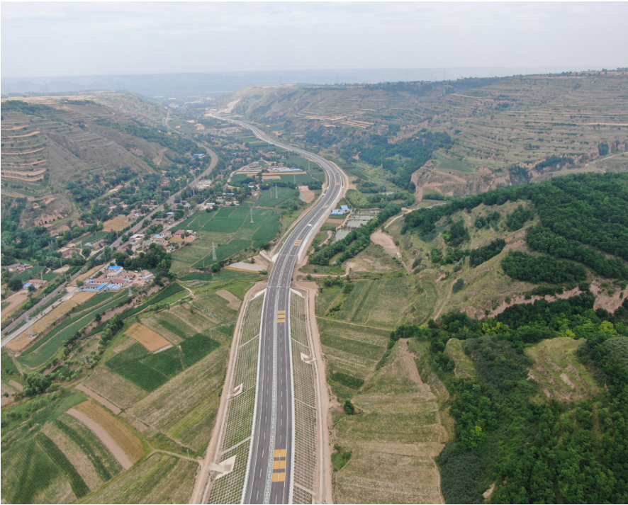
高速公路路基边坡综合防治
