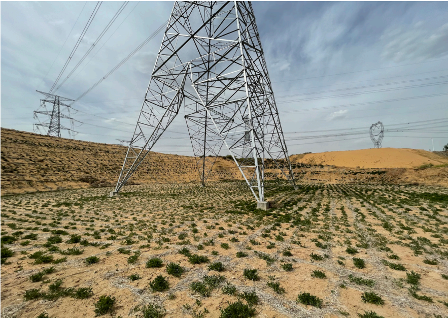
输变电工程塔基区沙障网格植草防护
