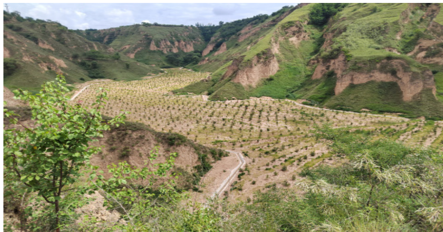
沟道型弃渣场两侧排水沟及渣面植物措施
