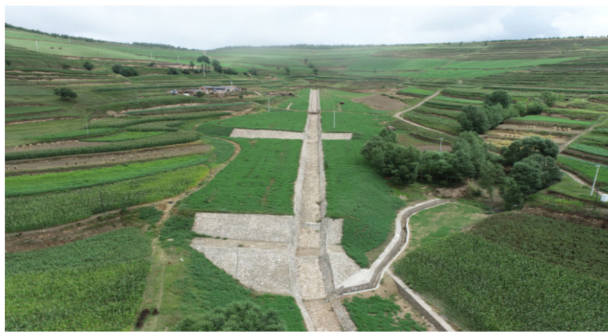
沟道型弃渣场综合防治
